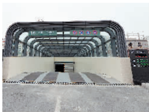
地下停车场入口。
